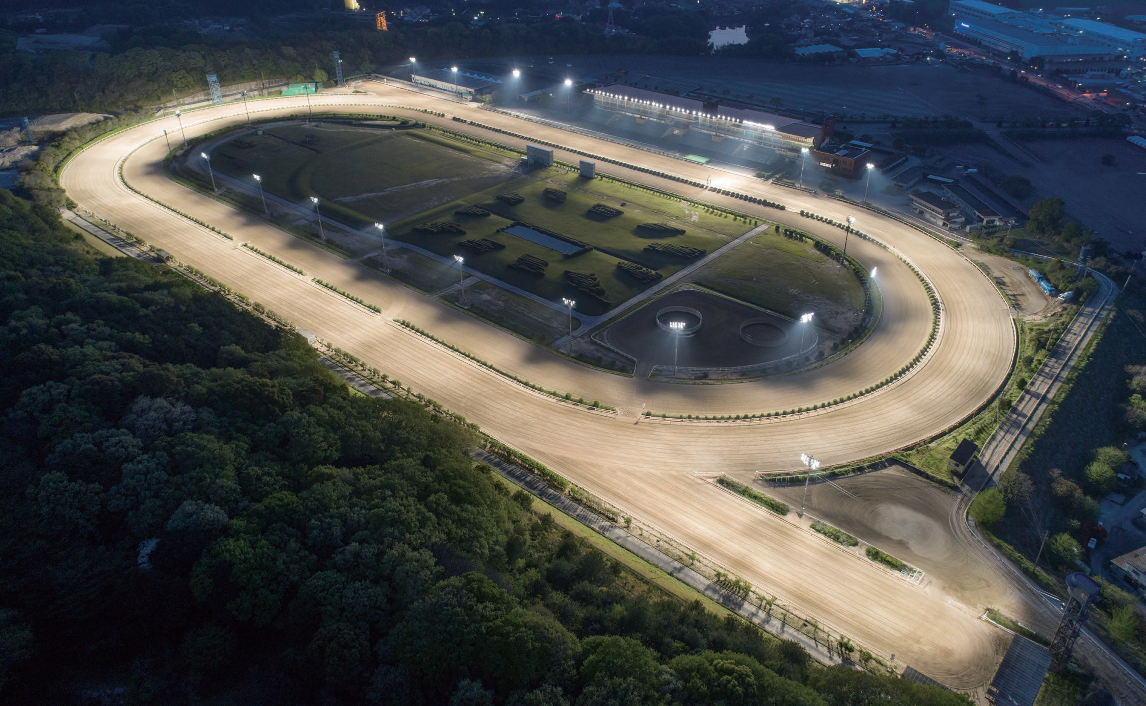
マルチフレクター(反射板)により、遮光ルーバなしでも周辺への漏れ光がありません。
